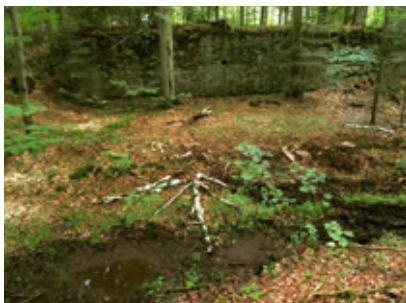
Fot. 8. Murowana, zbudowana z kamieni rampa kolejowa przy kopalni Ludwik (fot. J. Urban)
