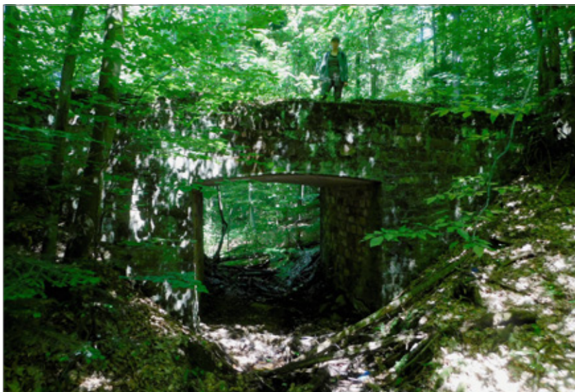
Fot. 6. Murowany przepust na trasie kolejki (BK)
