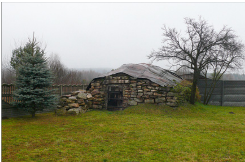
Fot. 1. Jedna z najlepiej zachowanych piwnic we wsi Odrowążek (Fot. ŁMi)
