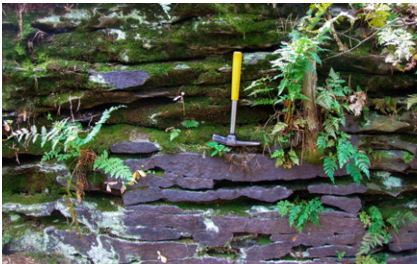
Fot. 11. Kamień Partyzancki, północno-wschodnia ściana o rzeźbie cienkolistewkowo-bruzdowej z widoczną jednak w dolnej części powierzchnia pokrytą naskorupieniem tlenków żelaza (Fot. JU 2008 r.)
