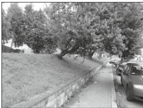
Fot. 2. Pochylone drzewa w wyniku pełźnięcia gruntu (al. Piłsudskiego) (WB)
