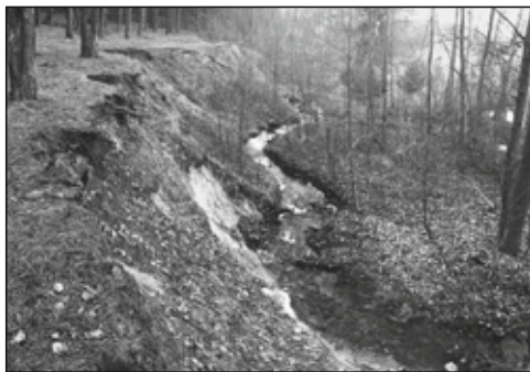
Fot. 5. Osuwisko w okolicy ul. Leśnej w Suchedniowie (MG)
