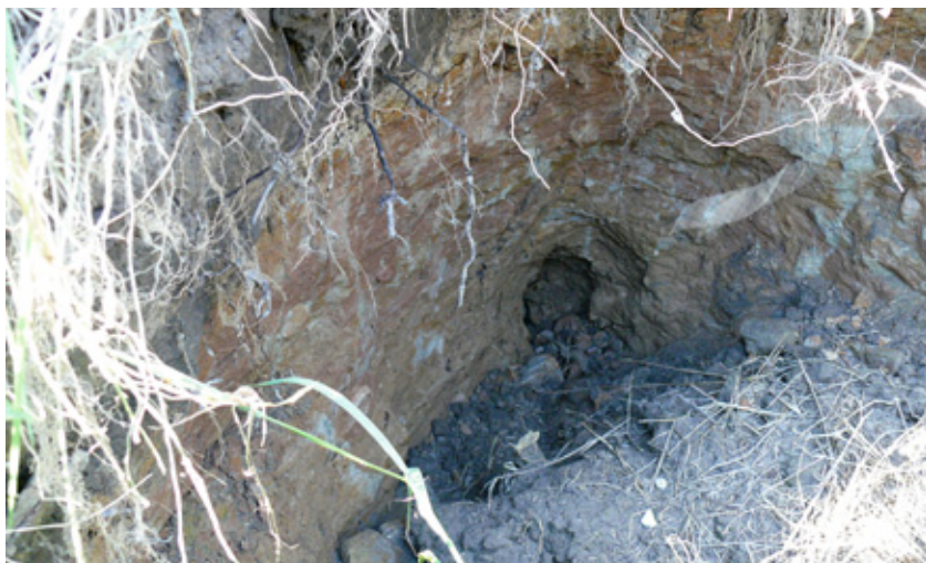
Fot. 4. Sinkhole (lejek krasowy) w rowie przydrożnym w Gostkowie (RS)
