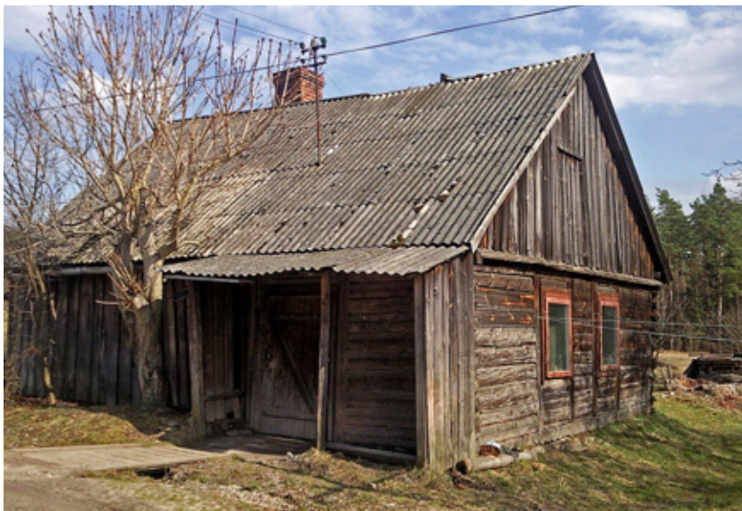
Fot. 2. Dom z ok. 1900 roku – Rędocin 4 (PK)
