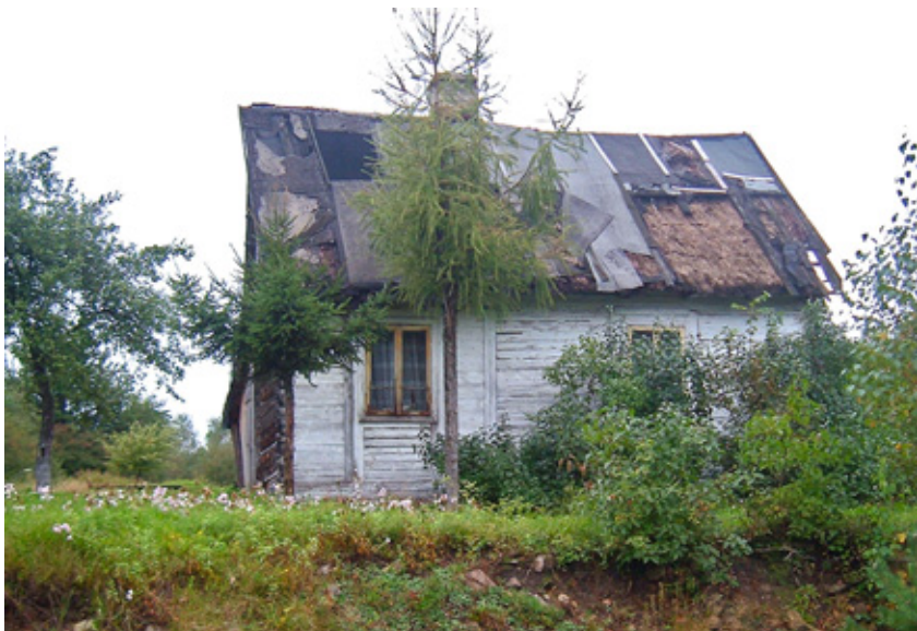
Fot. 4. Michałów 51 – dom został zbudowany około 125/130 lat temu (PK)
