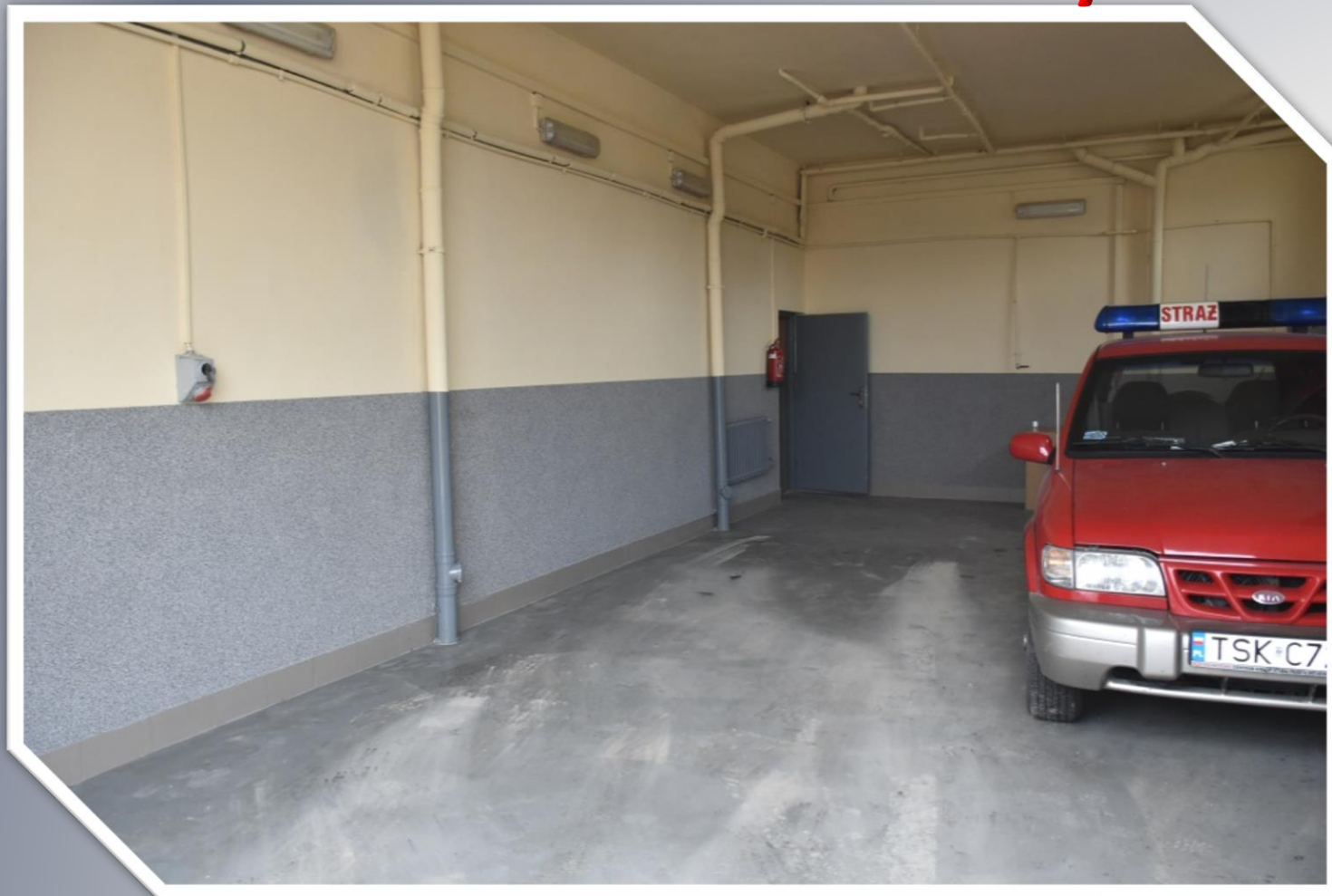
Wykonanie remontu stanowiska garażowego
