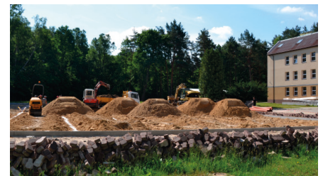
Fot. Ł.W. Trwają prace przy budowie boiska przy Zespole Placówek Edukacyjno-Wychowawczych w Skarżysku-Kamiennej.
